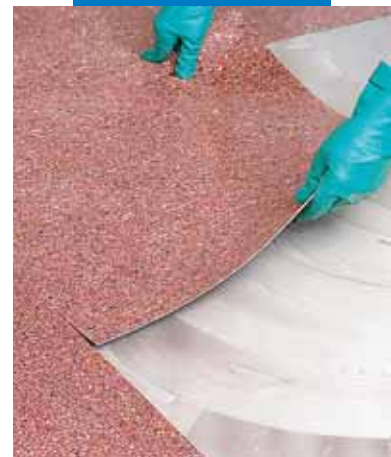
Colocación de pavimento de PVC con Adesilex G19
