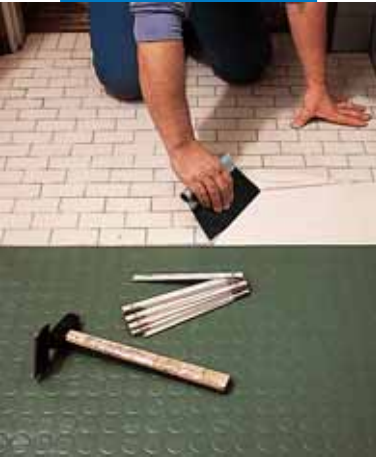
Aplicación del Adesilex G19 con espátula dentada
