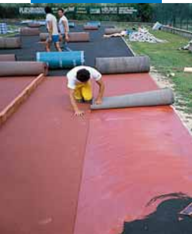
Colocación de goma deportiva con Adesilex G19
