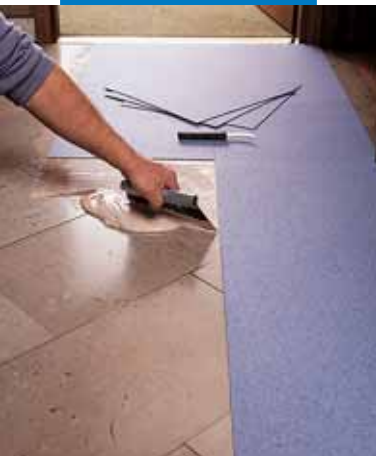
Colocación de PVC sobre soporte no absorbente con Adesilex G19
