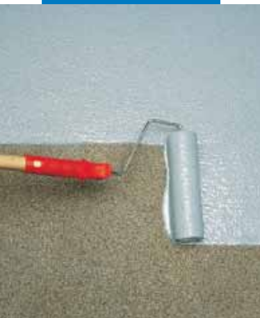
Aplicación de Mapecoat I 24 a rodillo
