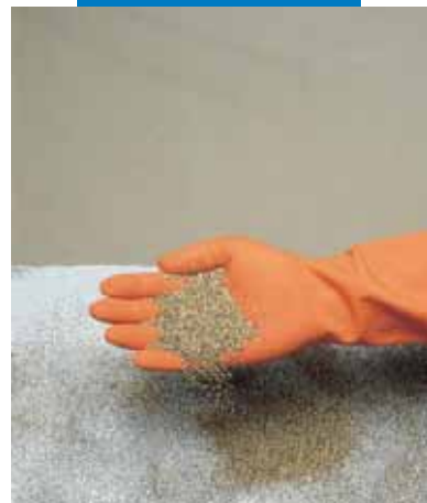
Espolvoreo de arena de cuarzo seca sobre Mapecoat I 24 fresco
