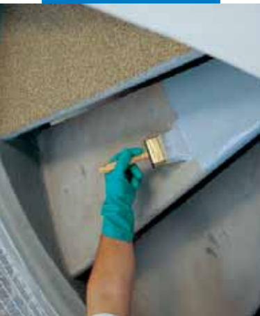
Aplicación de Mapecoat I 24 sobre hormigón
